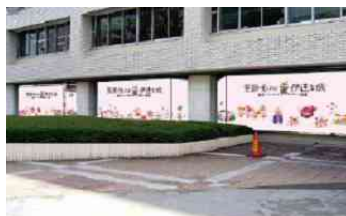
1階正面ガラス面
